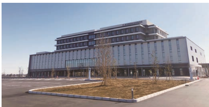
＜埼玉県済生会加須病院建設状況＞
