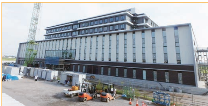
＜埼玉県済生会加須病院建設状況＞2021/8/25
