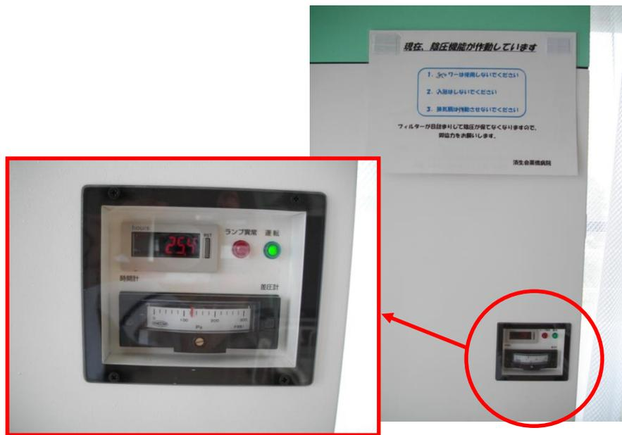
③下の写真に示すパウチパネルの時間と圧の数値と計測器の時間と圧の数値を比較し、部品の交換時期が過ぎていないことを確認してから、裏面（注意事項）を表記する。
